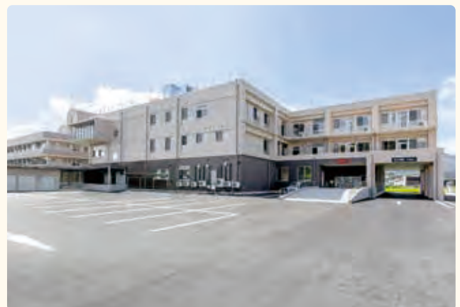
西棟北面側（救急出入口）
