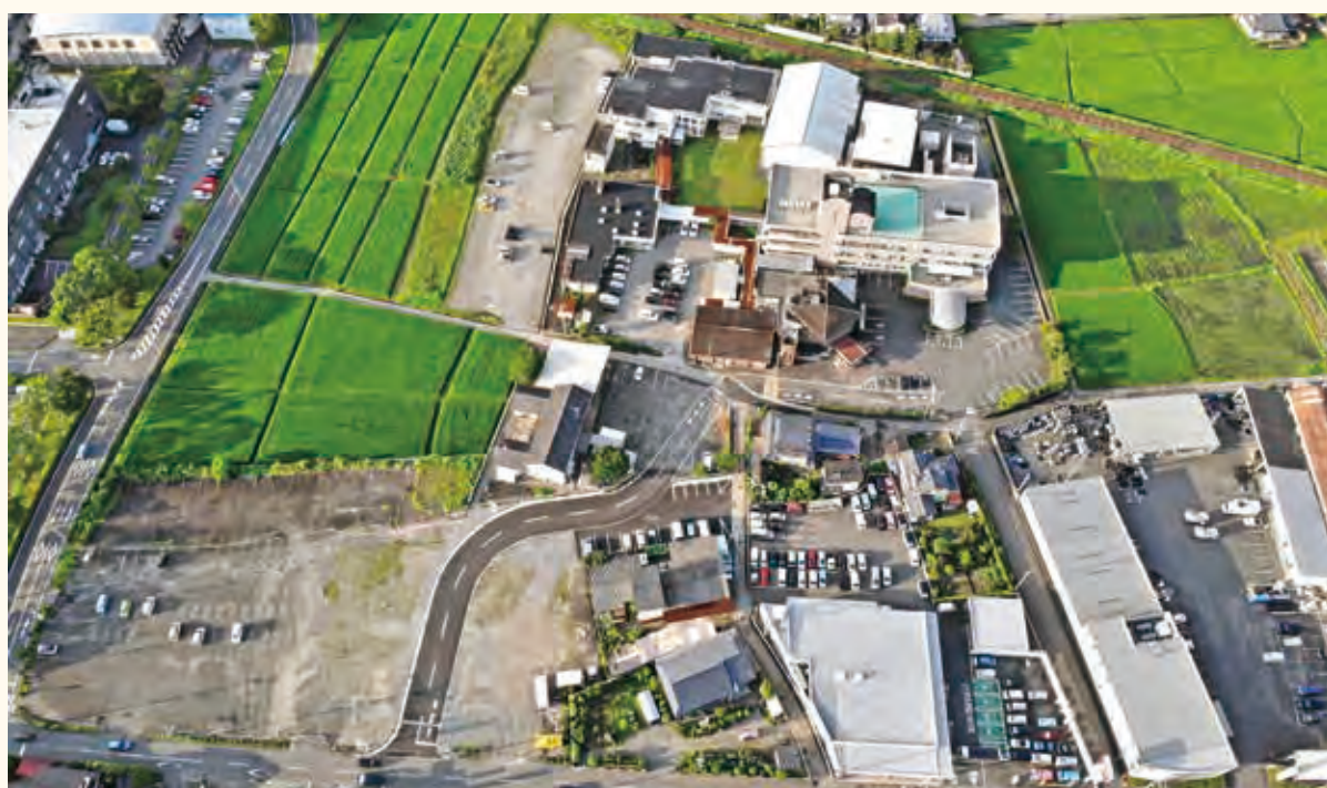
新棟建設前の空撮写真（北棟、作業療法棟、管理棟、薬局は取り壊された）
